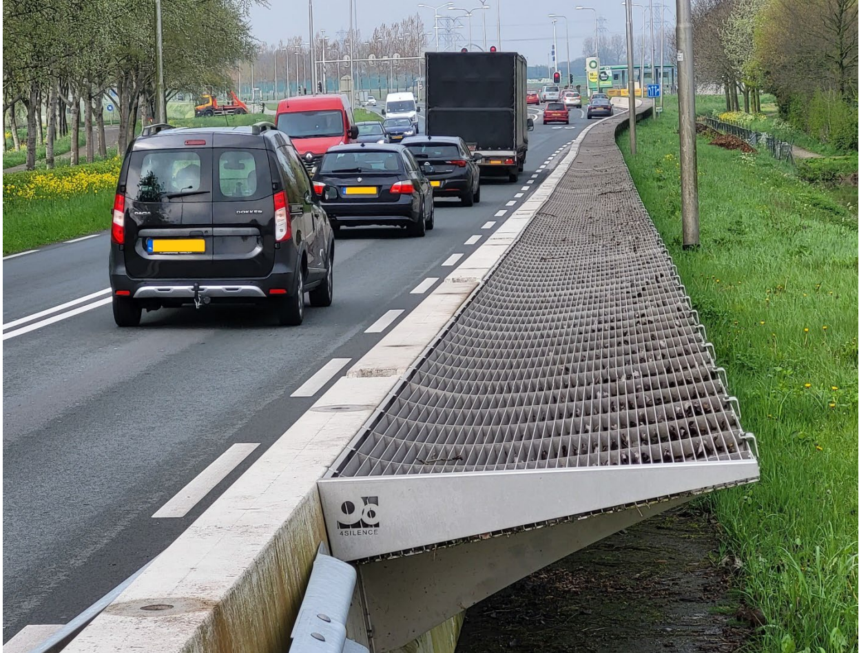
Afbeelding 12: Diffractor om het geluid af te buigen
