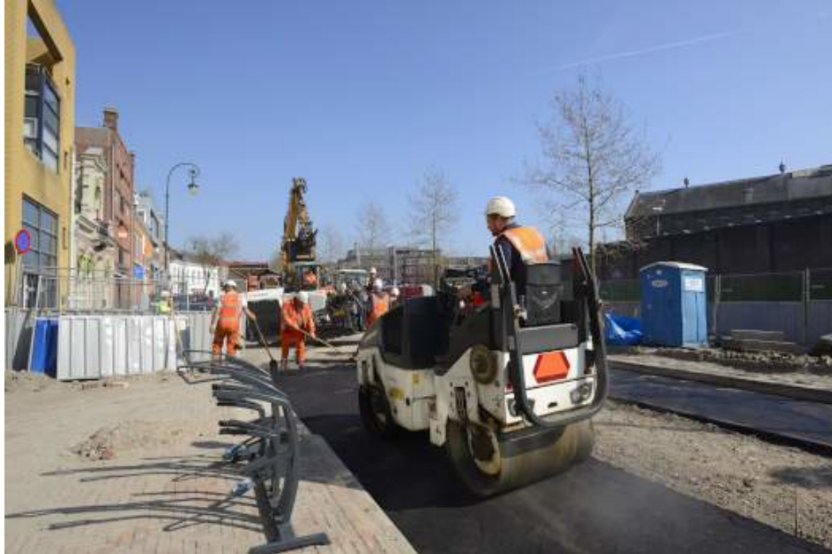
Afbeelding 2: Aanleg asfalt
