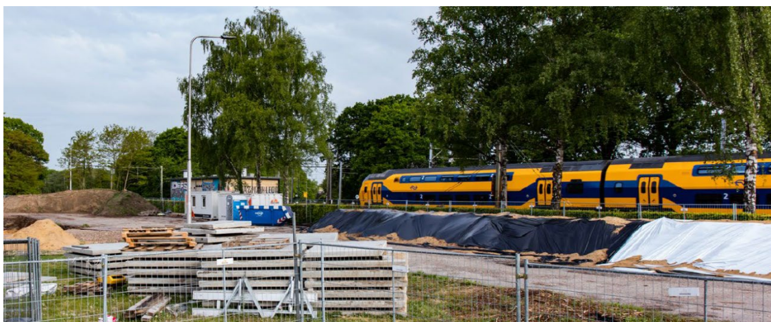
Afbeelding 13: Bouwplaats naast de spoorrails. Een trillingsgevoelige locatie
