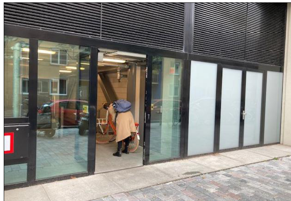
Voorbeeld fietsparkeren ingang Fenix I, Rotterdam.
