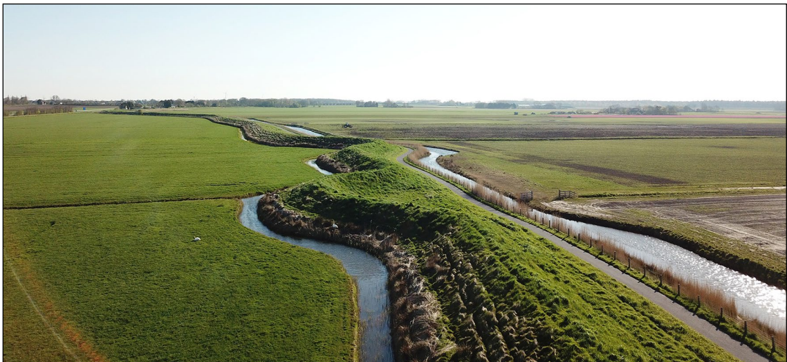
Afb. 8. De Stroeërdijk ten zuiden van Hippolytushoef.
