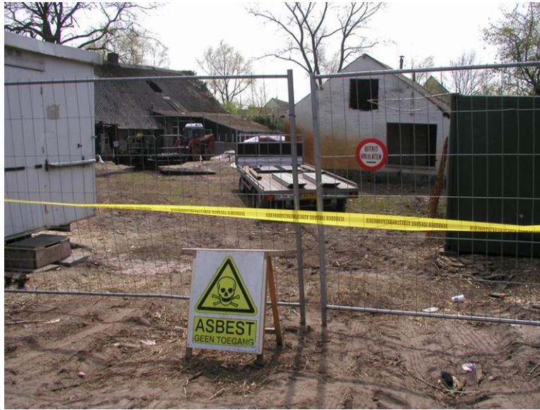
Figuur 17: Afscherming van een asbestverdachte locatie
