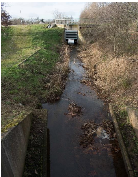
Afbeelding 4. Wylrebeek loopt over korte afstand in een normaalprofiel naar een volgende duiker onder een fiets- en voetpad parallel aan de toerit naar de A73 (foto genomen op 22-1-2021).
