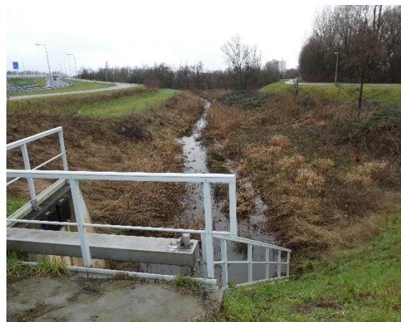
Afbeelding 5. De beek stroomt in een normaalprofiel dat gaandeweg overgaat in een moeraszone, waarvan de overloop via vistrappen uitmondt in enkele, achter elkaar geschakelde vijvers (foto genomen op 2-2-2021).
