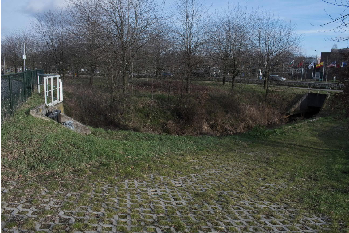
Foto 3: Wylrebeek tussen duiker onder Venloseweg (rechts) en duiker onder fietspad (links)
