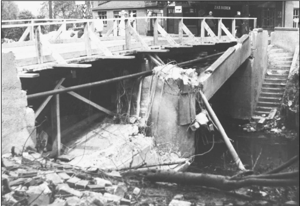
Figuur 8. De provisorisch herstelde brug, kort na de beëindiging van de strijd in mei 1940. Bron afbeelding: Bron afbeelding: beeldbankwo2.nl
