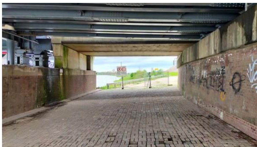
Figuur 6: lage kade bij IJsselpaviljoen en onder brug (afgesloten voor verkeer)
