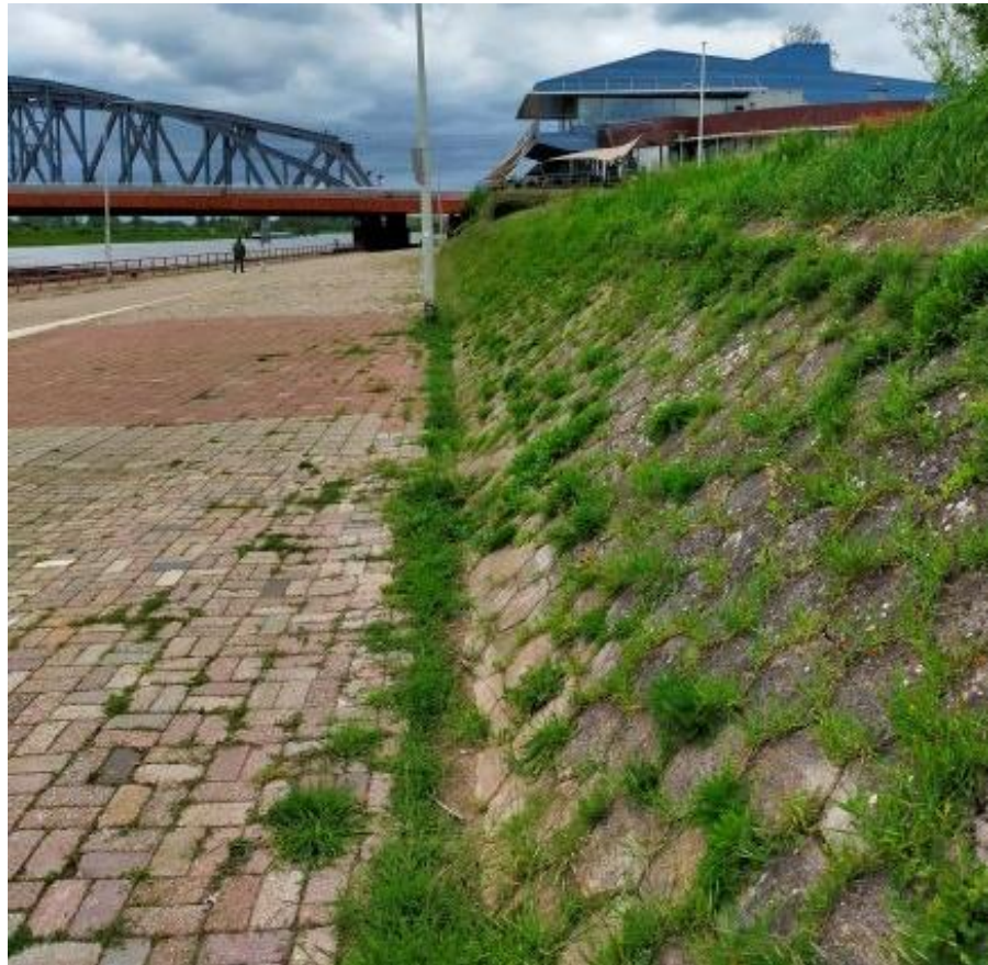
Figuur 9: hoge deel van de waterkering bij IJsselpaviljoen met zeskantstenen bekleding
