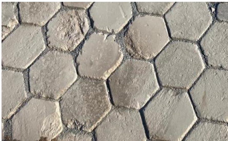
Figuur 13: zeskantstenen (bekleding waterkering in bestaande situatie)
