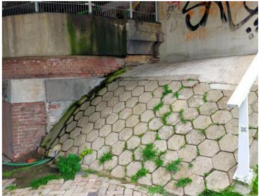
Figuur 4: waterkering IJsselkade aansluitend op landhoofd bruggen
