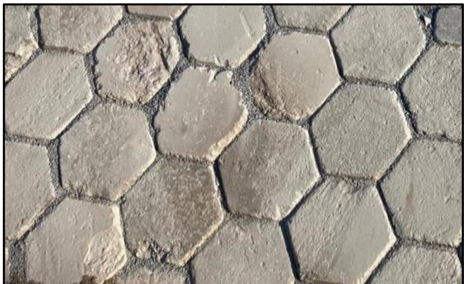
Figuur 6: zeskantstenen (bekleding waterkering in bestaande situatie).
