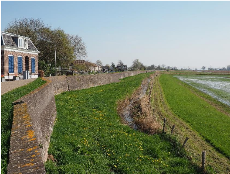
Afbeelding 3.5 De 'rechte' stenen muur met een verticaal golvend karakter dankzij de dijkvakken
