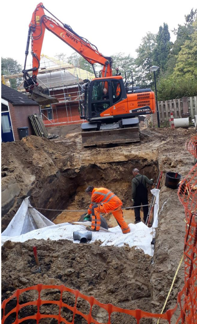
Afbeelding 21 Aanleg IT-rigool met lavakoffer in het Spicaplein
