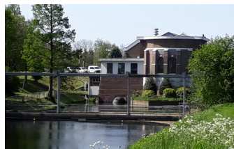
Zicht op het gemaal Leeghwater
