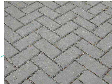
Betonstraatstenen bij parkeerplaatsen
