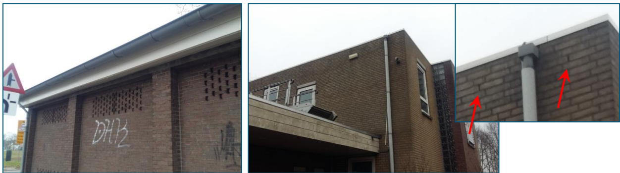
Figuur 3-1: Gebouwen met toegankelijke binnenruimten; mogelijk geschikt als vleermuisverblijf. Links de schottenbalkloods, rechts het complex bij de oude sporthal. Inzet rechts: rode pijlen geven open stootvoegen aan onder de dakrand.
