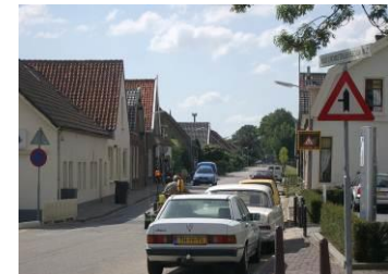
Beeld van de dijkbebouwing aan de Molendijk
