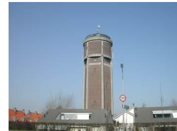
Beeld van de watertoren die achter de dijk ligt
