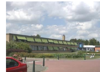
Horizontale geleiding bij het woningcomplex aan de Bernhardstraat.
