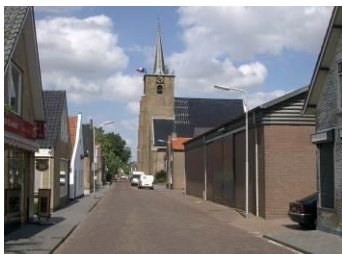
Gevels van de Torenstraat met wisselende geveloriëntaties.
