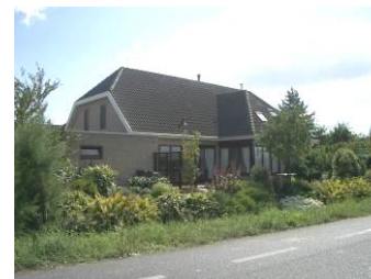
Individuele woningbouw aan de Kreupeleweg in Klaaswaal
