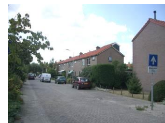
Doorgetrokken dakvlak verstoort de eenheid van het bouwblok.
