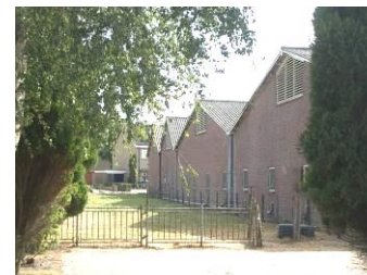
Een aantal gekoppelde metselwerkhallen aan de Krenpeleweg.
