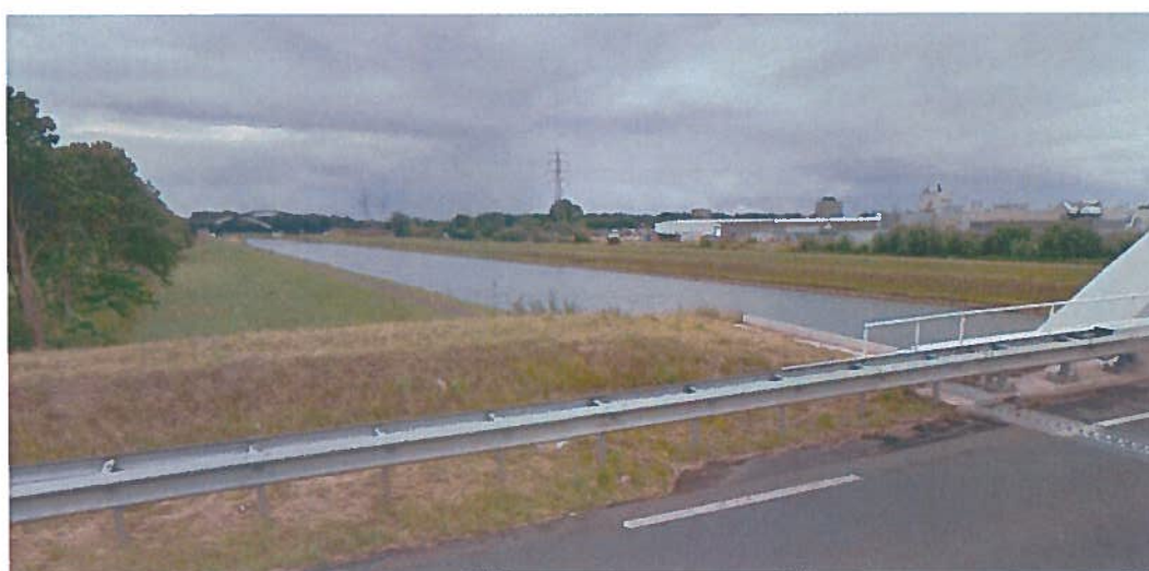
Afbeelding 1.3 Hoogspanningsmast Tennet binnen projectgebied. Bron: Google Maps
