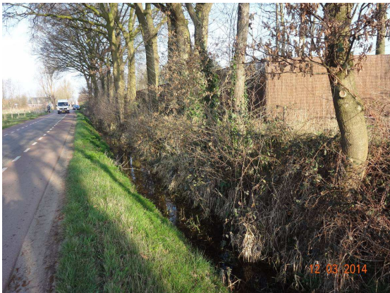
Verbreiding met natuurlijk talud en kap enkele bomen:
