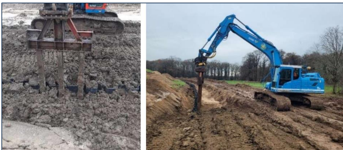
Figuur 5.5: Rupskraan met damwandstamper ontwikkeld voor kunststof heaveschermen.
