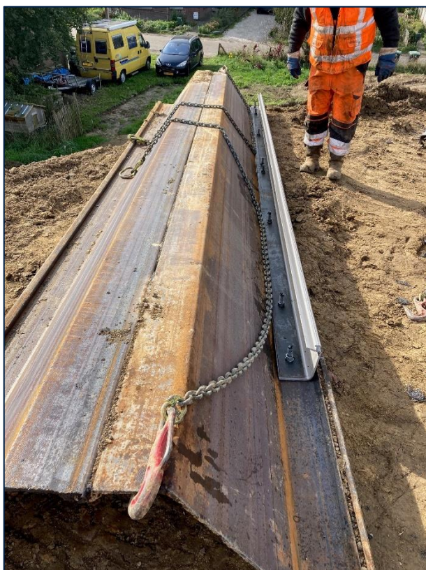
Figuur 5.1: Overgang tussen staal en kunststof.
