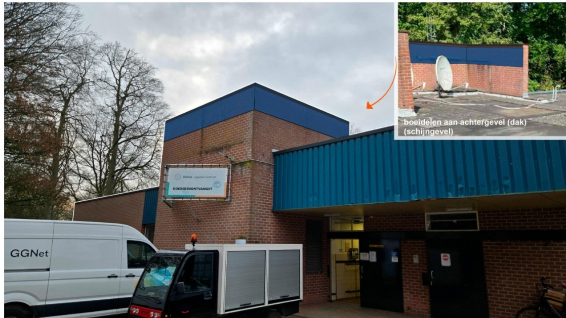
Figuur 4 Op deze afbeelding is weergegeven hoe de boeiboorden op de bebouwing worden geplaatst (in blauw weergegeven).
