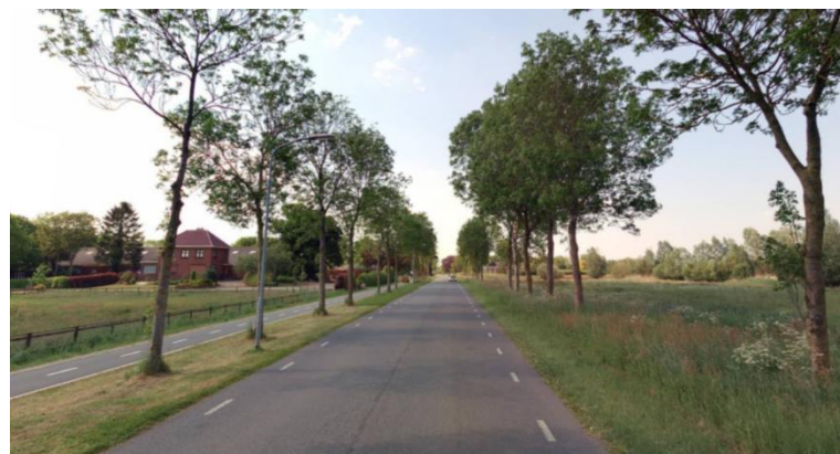
Figuur 5.4: Inrichting van Oostereinde (ETW60 I) met kantmarkering en geen tussenmarkering. Daarnaast is er een vrijliggend fietspad aanwezig.
