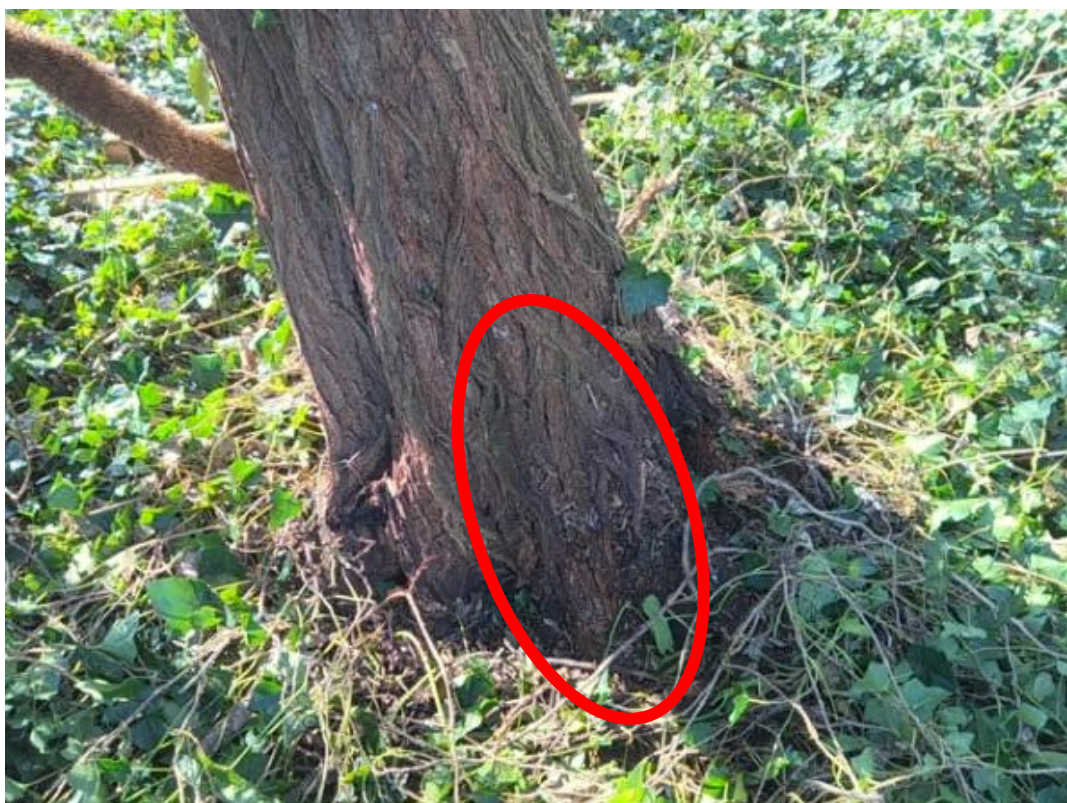
Foto van de scheur uit onderzoek handmatig 1:
