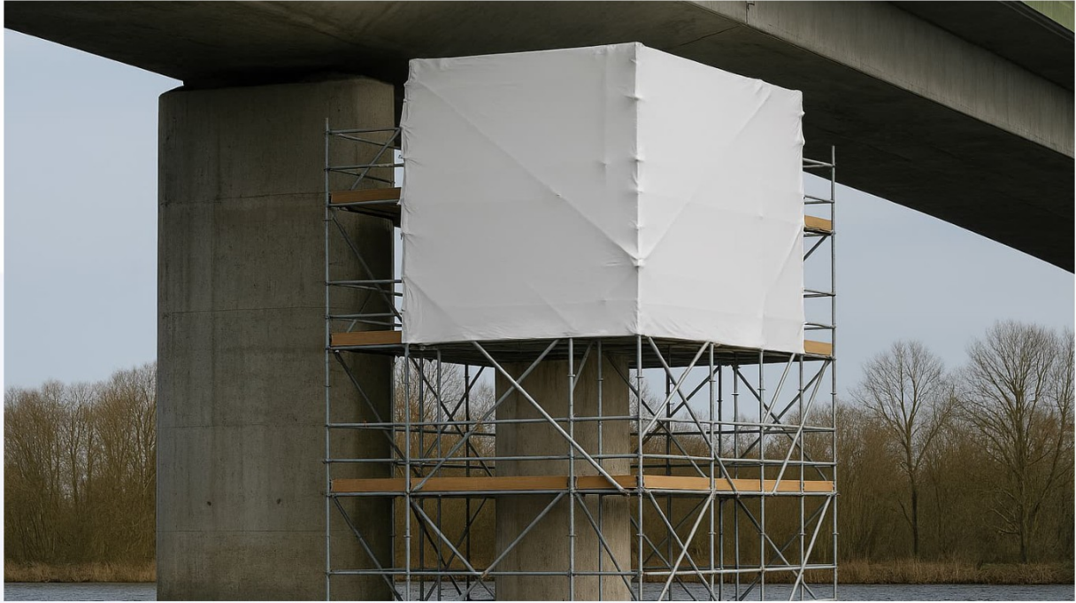
Figuur 4: Visualisatie hulpconstructie steunpunten
