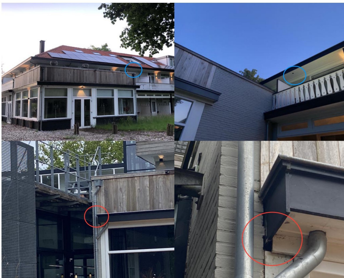
Afb. 3.1, 3.2 (boven) Foto's van de locatie van vleermuizen, één verblijfplaats Gewone dwergvleermuis (2025).
