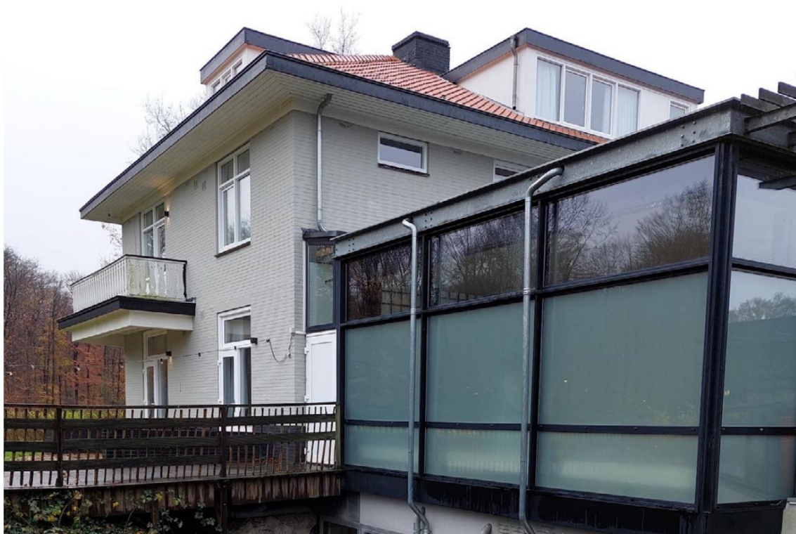
Afb. 1.3: Beeld van het pand aan de achterzijde met een goed beeld van de dakkapellen en de brede dakoverstekken. Op de voorgrond een recente uitbouw met daaronder de kelderruimte. Foto [redacted] 22 nov. 2024.
