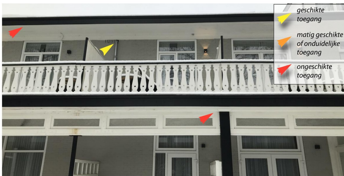
Afb. 2.6: Beeld van de verdiepingvloer met balkons, goed aangesloten kozijnen en dakoverstekken. Toegangen tot de spouw via de hemelwatertoevoeren en ventilatieroosters.
