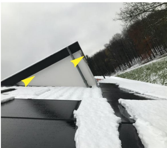
Afb. 2.9: Dak op de 2e verdieping met platte pan, zonnepanelen en dakkapel.
