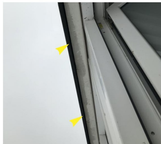
Afb. 2.10: Detail van de kierende bloeidelen van de dakkapel. De ruimte is groot genoeg voor vleermuizen.
