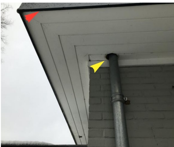
Afb. 2.7: 1e verdieping met toegang tot achter het knieschot via de hemelwatertoevoer, veegplek aanwezig.
