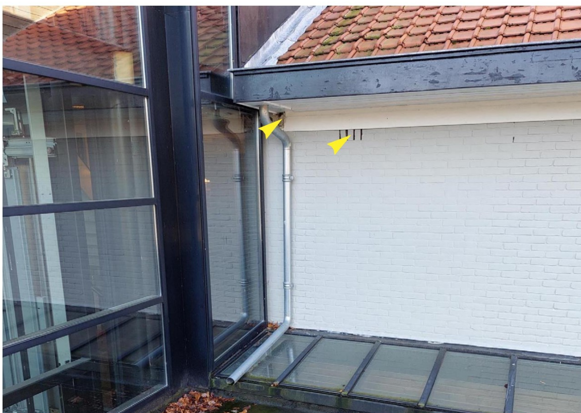
Afb. 3.5: Beeld van het dak (2e verdieping), zonder specifiek onderzoek zijn geen werkzaamheden wenselijk aan de gevel (geschikte toegang voor vleermuizen via spouwventilatie), de dakkapel (links) met wijkende boeiplanken en het dakoverstek (invliegopening achter de hemelwatertoevoer). Foto [REDACTED] 22 nov. 2024.
