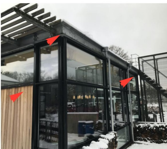
Afb. 2.4: Begaande grond met uitbouw van staal, glas en houten bekleding zonder mogelijke verblijfplaatsen.
