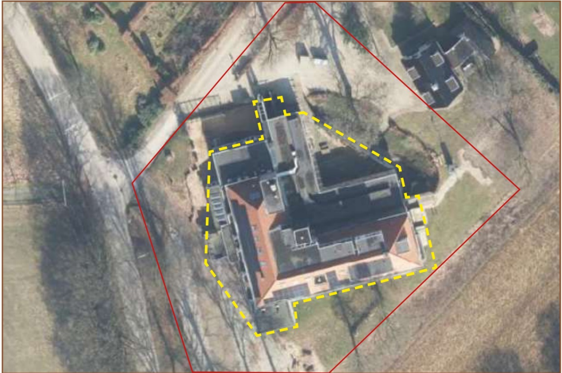
Afb. B.1 - Globaal overzicht te renoveren gebouw (geel kader) en het te herinrichten omliggende gebied (rood kader). Rechtsboven de bedrijfswoning, die buiten de werkzaamheden valt.
