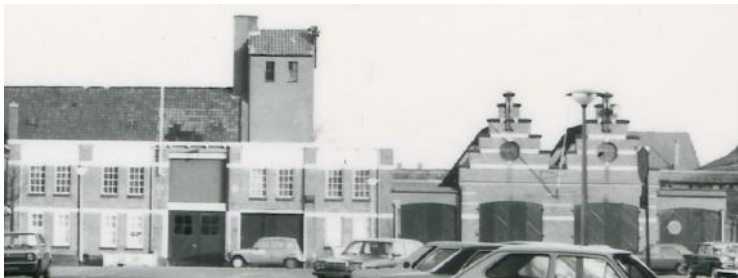
1980, voormalige brandweerkazerne Beeldbank Groningen, coll. Groninger Archieven
