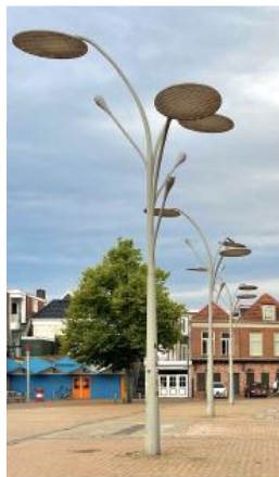
bestaande, expressieve lichtmasten
