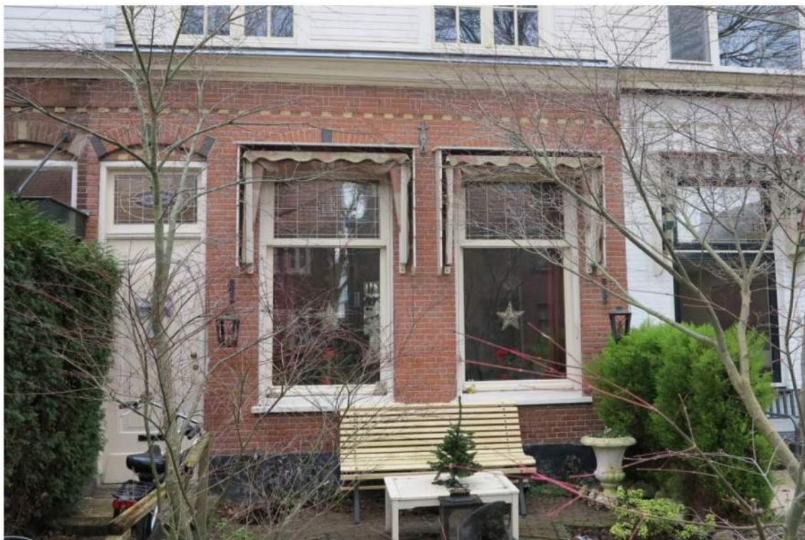
Foto 5 – voorgevel buurpand nr.8 met nog de oorspronkelijke gevelindeling
