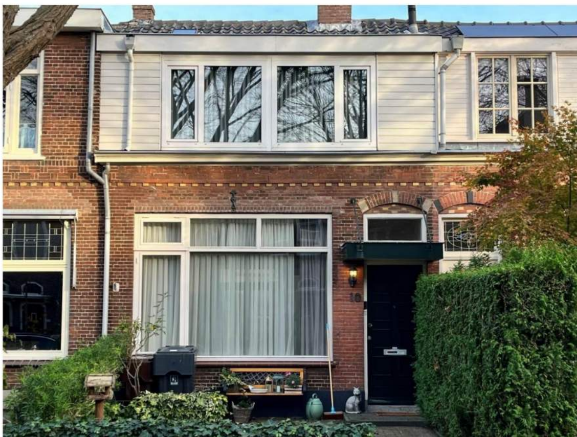
Foto 2 – voorgevel nr.10 met gewijzigd kunststof kozijn dakkapel en houten kozijn beganegrond
