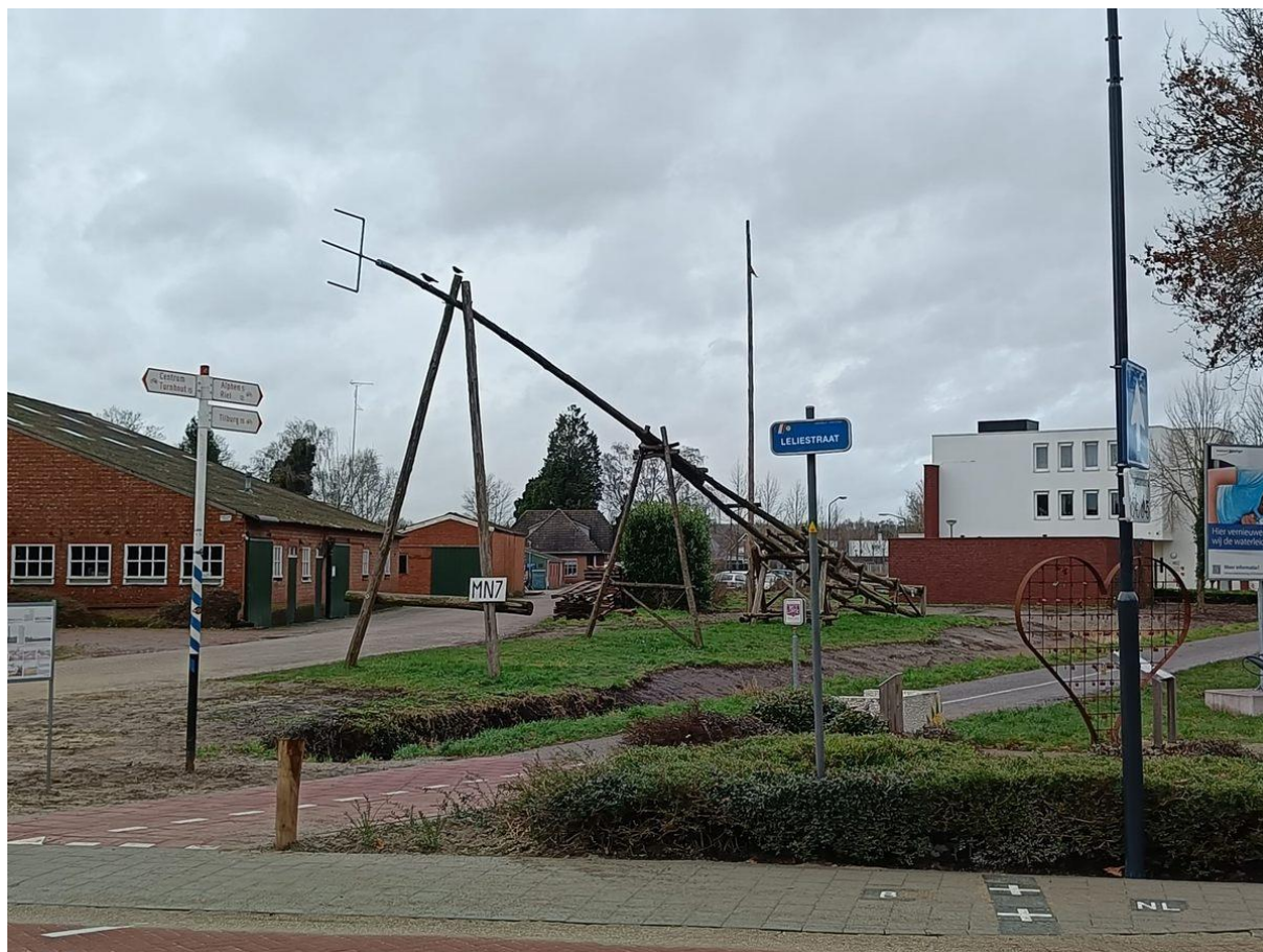
Figuur 43. Zendmast MN7, gelegen op de grens van een enclave. (Zendstation MN7 – Baarle-Hertog, Belgium - Atlas Obscura).
