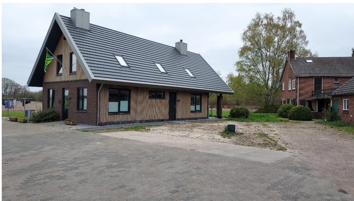
Figuur 2. Gebouw A
