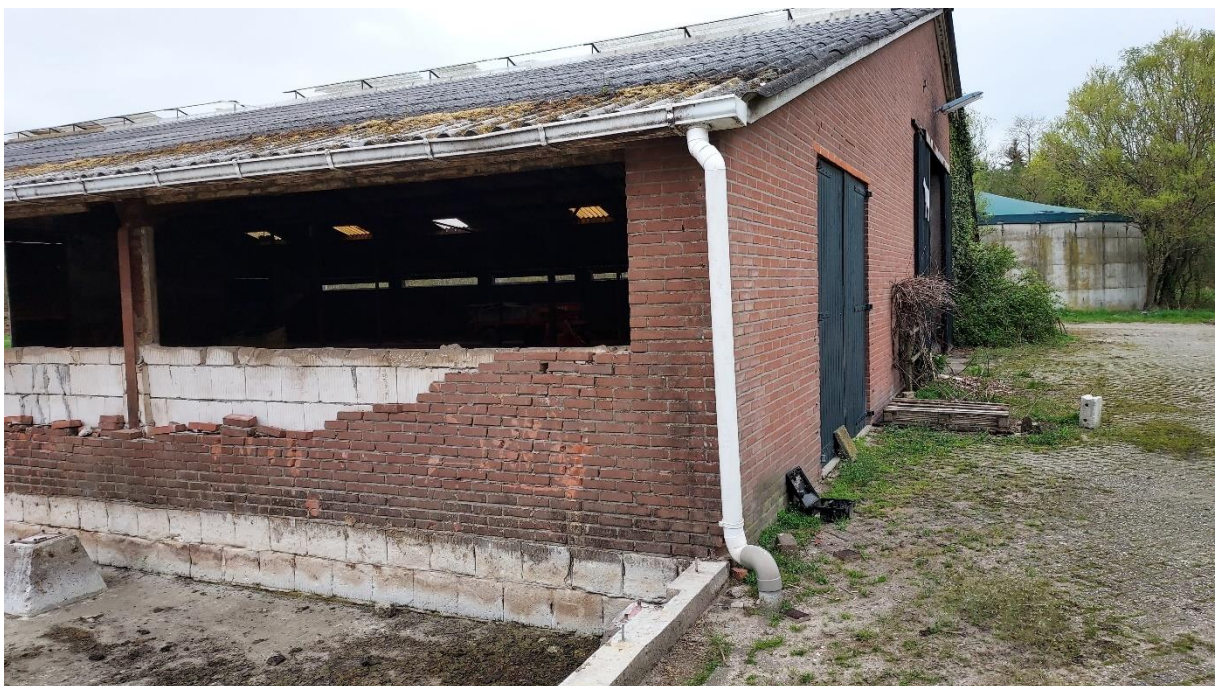
Figuur 7 Gebouw C melkveestal
