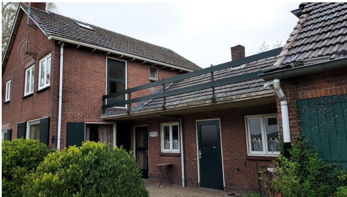
Figuur 5 Gebouw B oude dienstwoning
