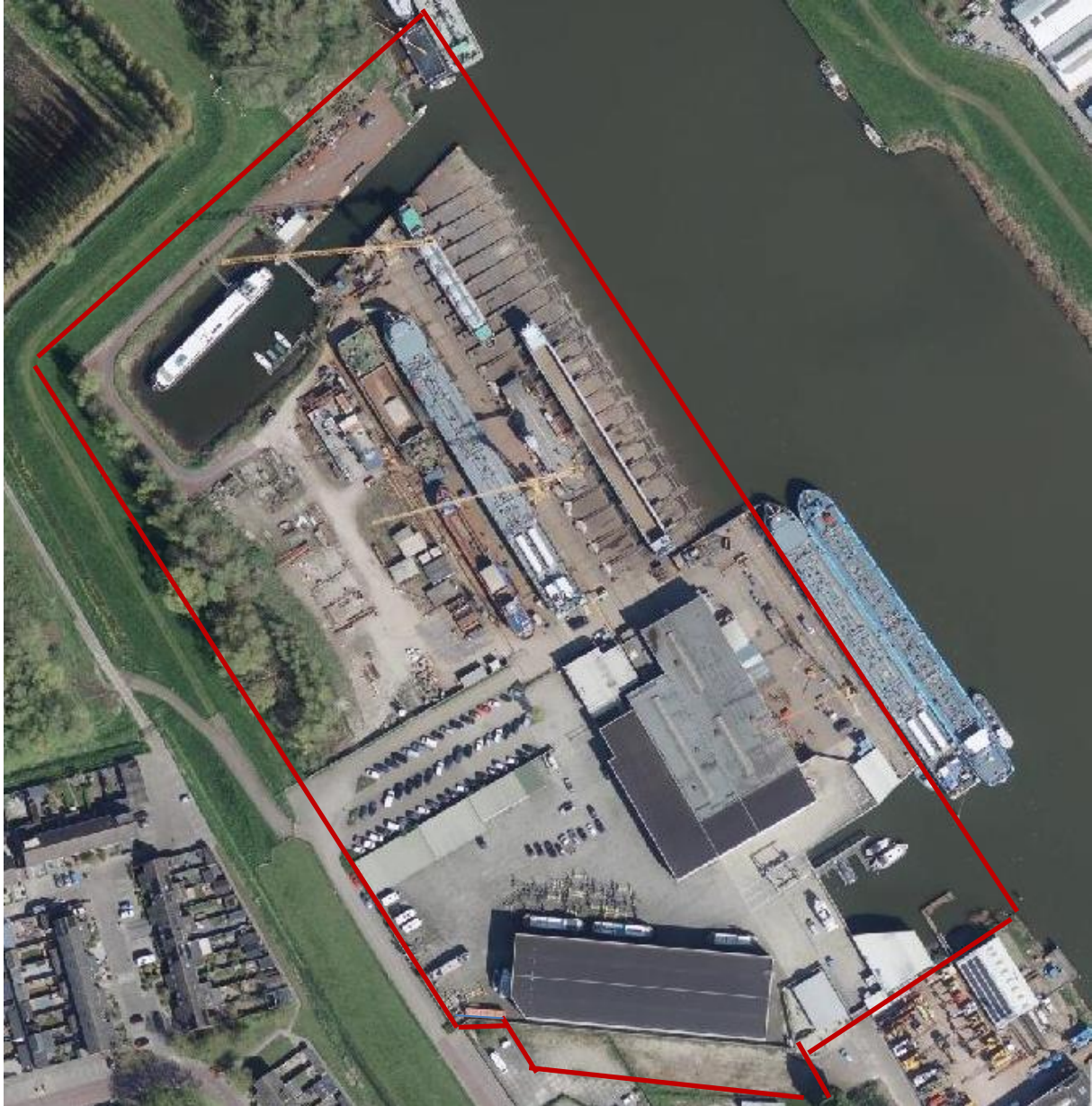
Afbeelding 1: Luchtfoto locatie (met aanduiding projectlocatie)
