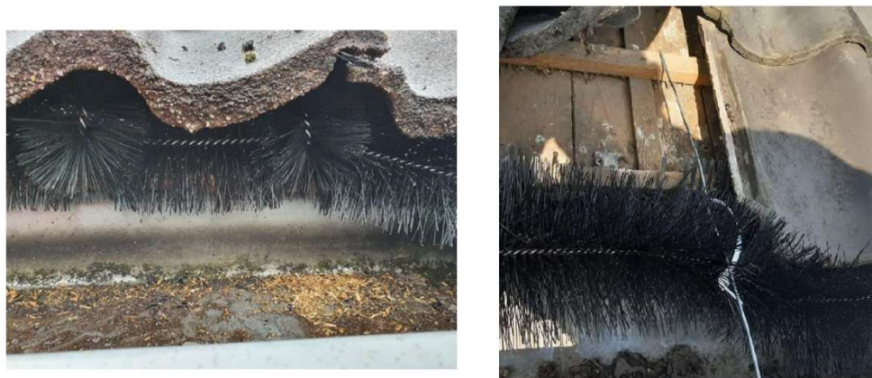
Figuur 4: Dichtzetten van goot met spouwborstels. Borstels met harde haren (maximaal 12 centimeter doorsnede) en korte borstels in holtes om goed af te dichten (links). Bron: Loo Plan. Vastzetten met borstelhaak ter voorkoming loshalen door vogels of marters (rechts). Bron: Unitura.
