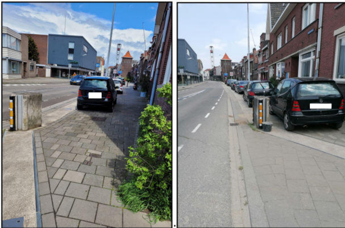
Figuur 1: zichtbare constructies tbv demontabele verhoging met linksboven van de linker afbeelding de locatie van het appartementencomplex.
