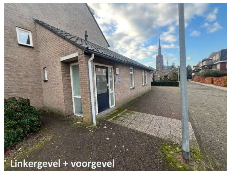
Voorgevel Kloosterhof 1A
