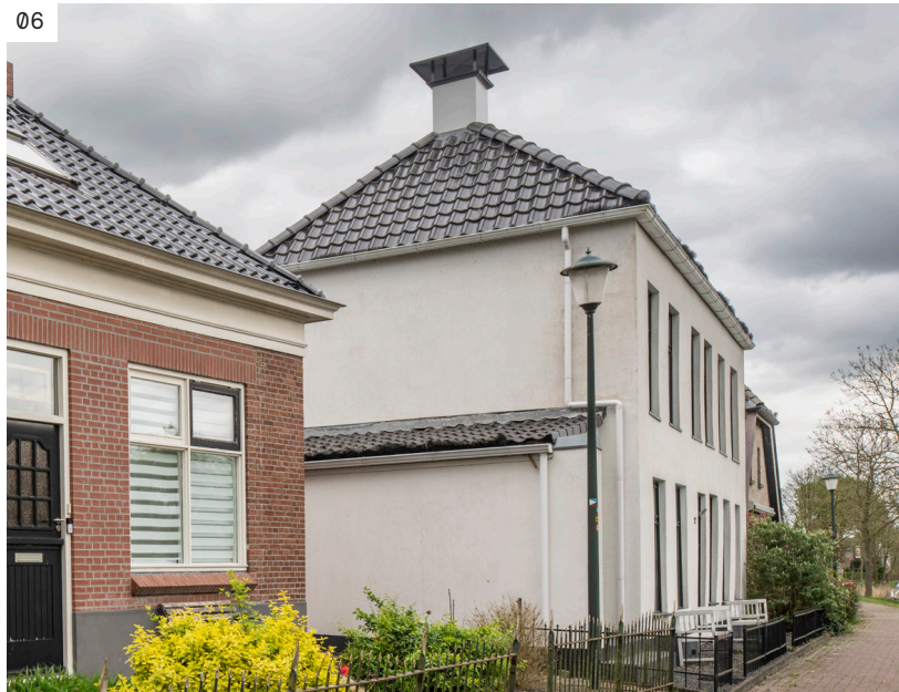
06 Zicht vanaf de hoek Damsterdiep/Trekweg. Het voorhuis heeft een gestucte gevel; de zijgevel is dichtgezet en voorzien van een aanbouw die vrijwel doorloopt tot de voorgevel aan de Trekweg. (Foto: Harry Cock)
