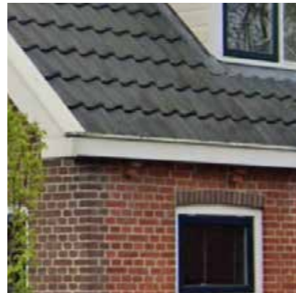
Eenvoudige houten goot met gemetselde gootklossen
