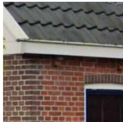
Eenvoudige goot op gemetselde klossen
