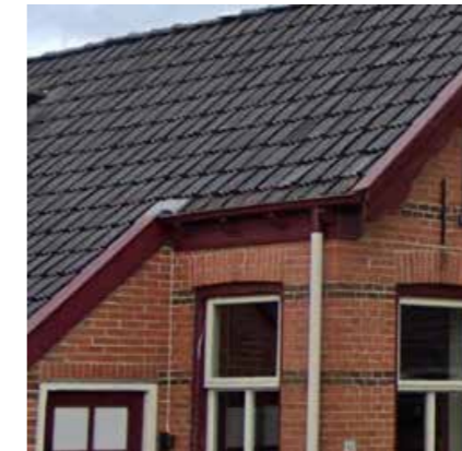
Geprofileerde houten goot met gootklossen en fries
