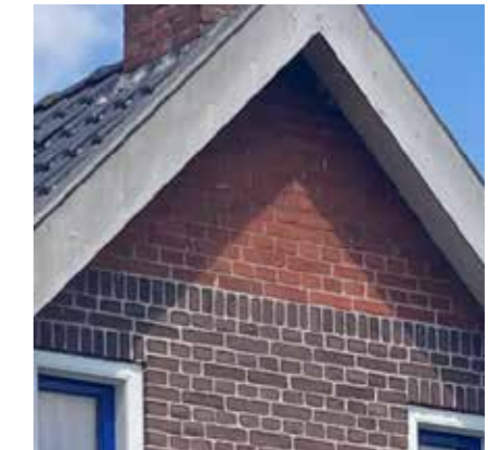
Gemetselde topgevel accent
