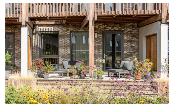
ondiepe buitenruimte onder brede leefgalerij
