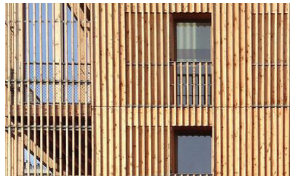
structuren lopen door
