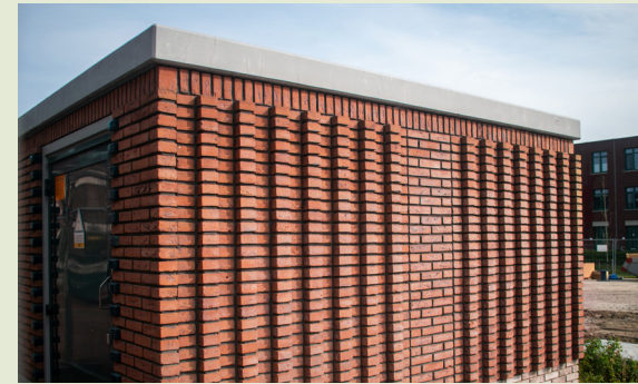
trafo in stijl aangrenzende architectuur
