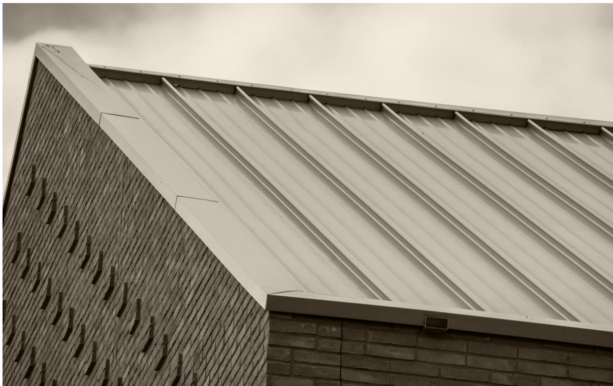
krachtige vormen door strakke dakranden
