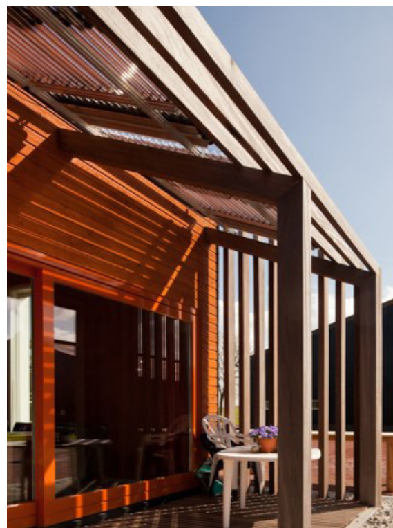
schaduw pergola en veranda met grote gevelopeningen
