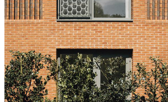
structuren dmv rijk metselwerk
