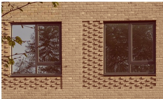
vlakvorming en nuance door rijk metselwerk
