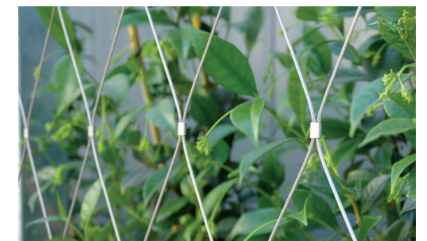
duurzame oplossingen voor gevelbegroeiing
