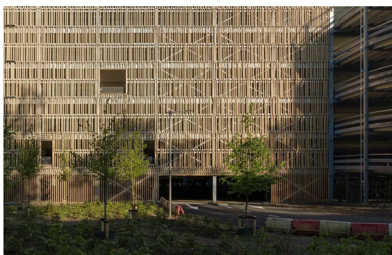
houten gevels met sparingen op systeembouw
