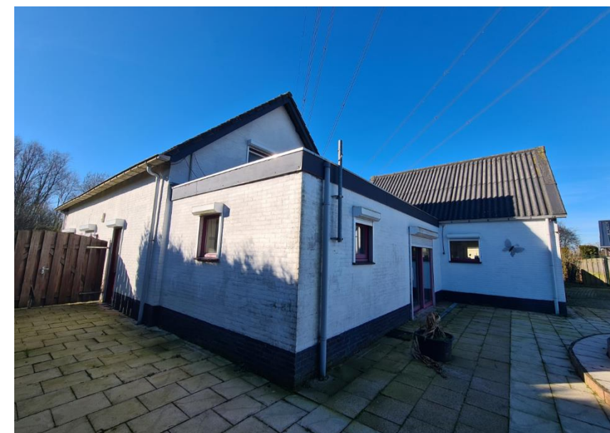
Figuur 7: Achterzijde bebouwing vanuit het oosten van het perceel
