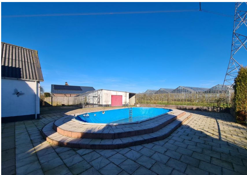
Figuur 6: Achterzijde perceel
