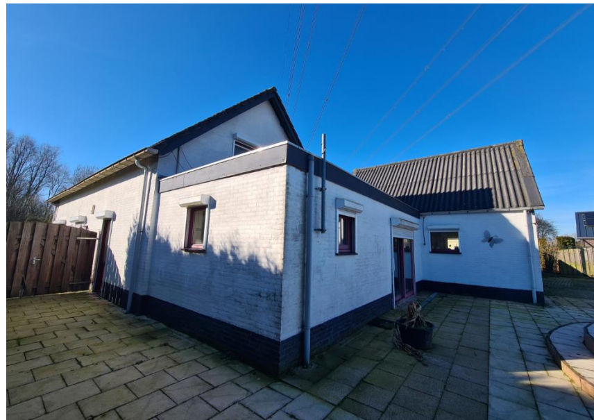
Figuur 4: Achterzijde bebouwing vanuit het oosten van het perceel
