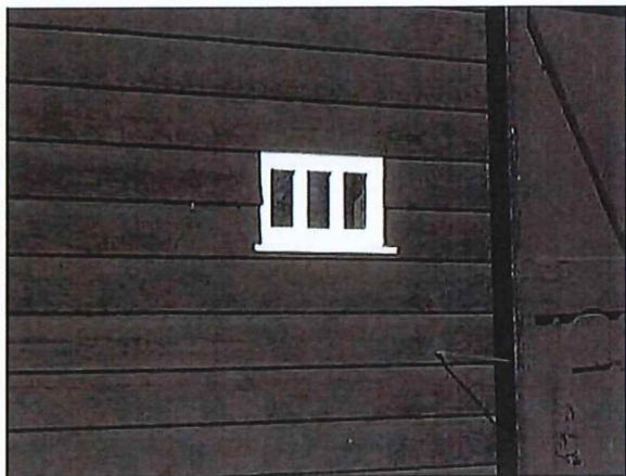
referentiebeeld kleinschalige, horizontale gevelopening in potdekselwerk deelgebied 1 (bron: Rothuizen)
