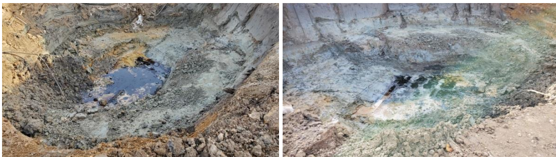
Afbeelding 4.2: Visueel zichtbare verontreiniging op 2,5 m-mv
