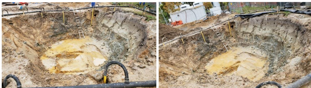
Afbeelding 4.4: ligging bronbemaling en bereiken einddiepte ontgraving
