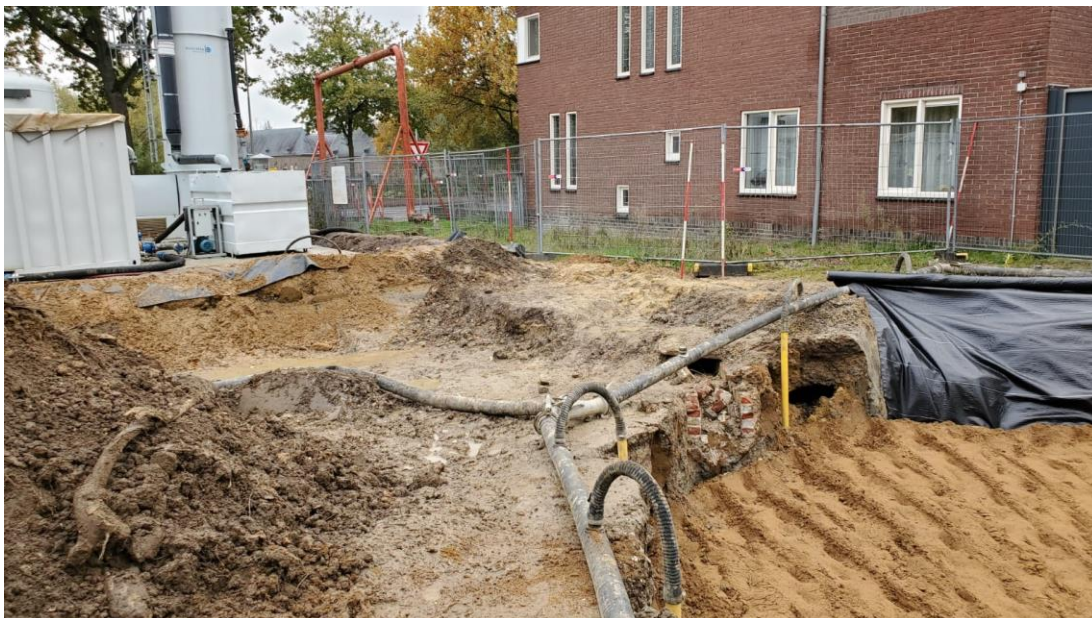
Afbeelding 4.5.: deel van wand 4, waarlangs het geotextiel is aangebracht
