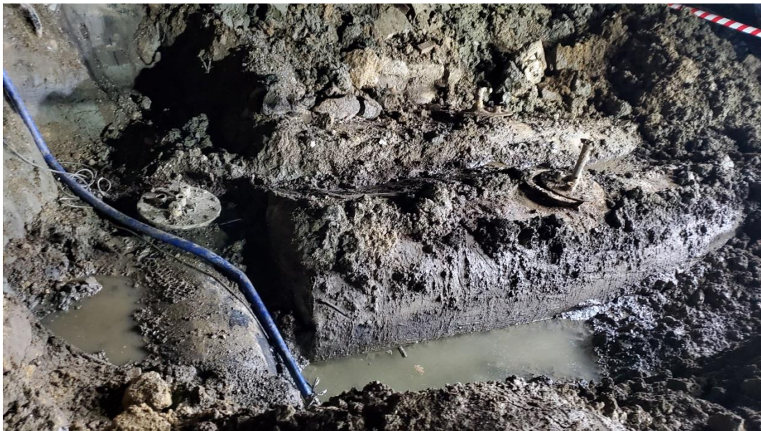
Afbeelding 4.1: De drie aangetroffen tanks
