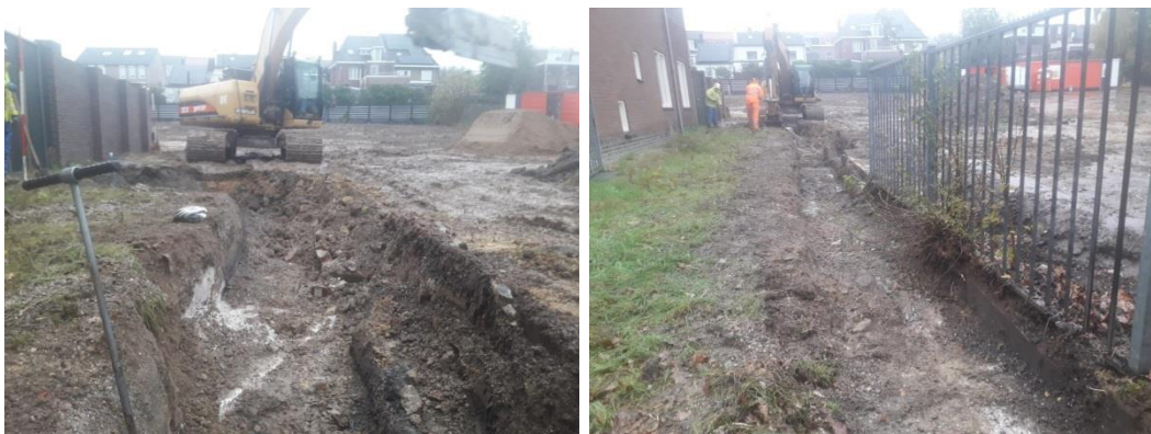
Afbeelding 4.6: ontgraving geul (uitspoelzone)
