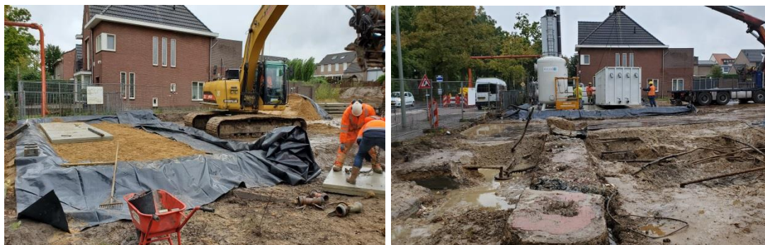
Afbeelding 4.3: Opstelplaats grondwaterzuivering en plaatsing grondwaterzuiveringsinstallatie
