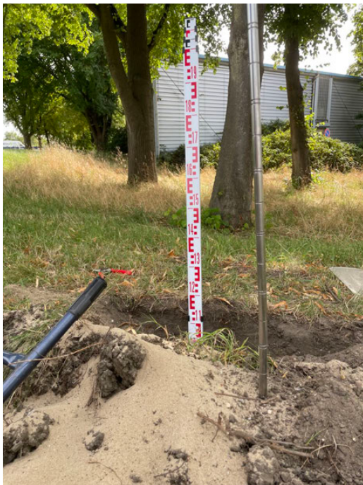
Figuur 3.8 proefsleuf ten noordwesten van boom 8
