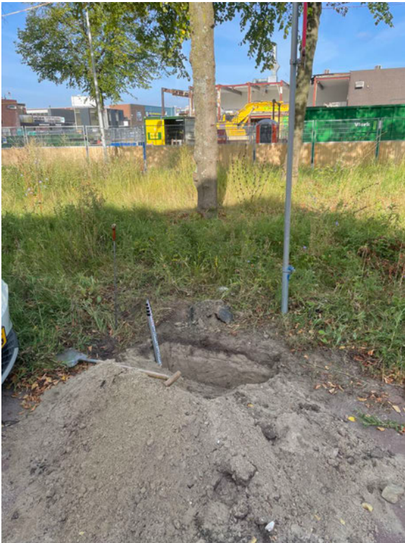
locatie proefsleuf #27 (linde) langs fietspad wz
