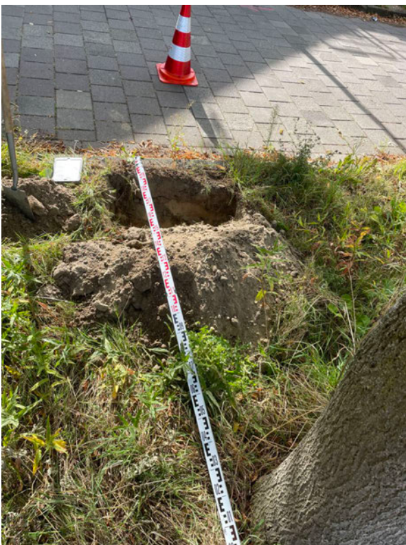
locatie proefsleuf #23 (es) langs fietspad wz
