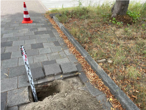
locatie proefsleuf #16 (linde) in het fietspad wz
