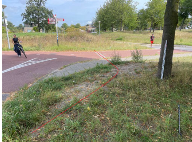
Figuur 3.7 recente wortelschade voor kabel/leiding (rode lijn) vlak langs boom 11 (rechts)
