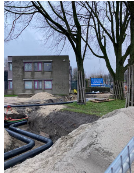
Figuur 3.4 Aanleg warmtenet bij de iepen nr. 28 (links/noord), 30 (rechts/zuidoost) en 29 (rechts rand foto/zuidwest); foto PFOA 13 december 2023.
