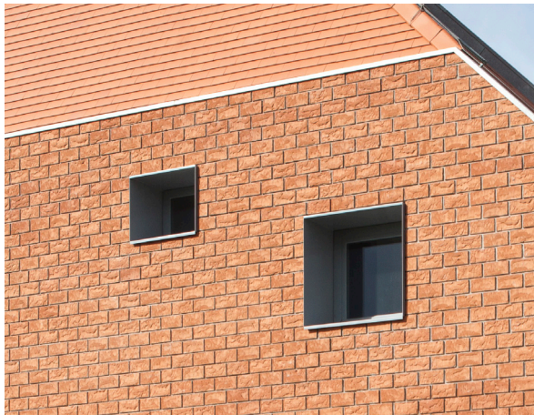
Hoogwaardige details: verdiepte kozijnen met zinken kader, en verholen goot.
