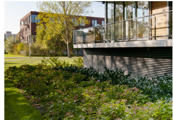
terugliggende open halfverdiepte parkeerkelder met natuurlijke ventilatie (met transparant hekwerk aan alle zijden) in het groen.
