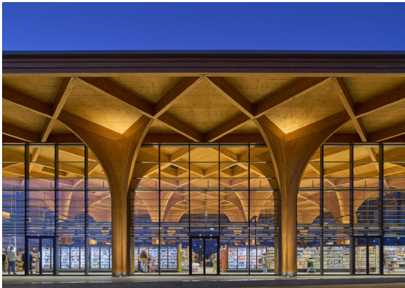
supermarktplint heeft een royale transparante houtconstructie aan de entreezijde.
