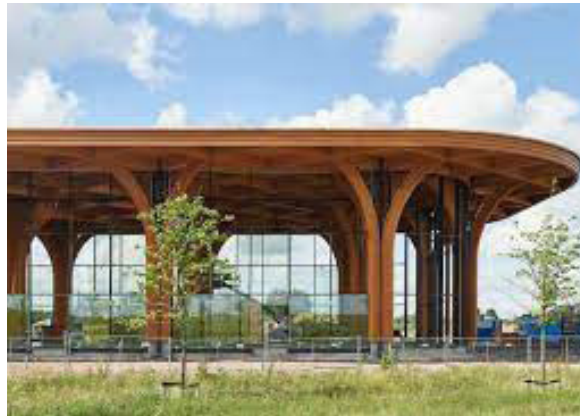
warne sfeer door gebruik van hout, met gedetailleerde constructie. De installaties buiten het zicht van bezoekers en bewoners appartementen.
