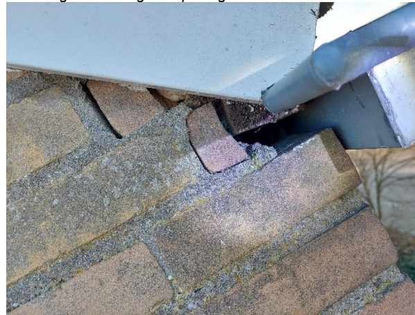
Afbeelding 4. Geïnspecteerde plekken met poreus materiaal op kopgevels woonblokken 117 – 131.
