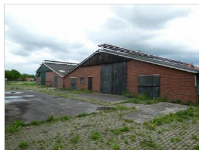
Figuur 2.5 Zuidelijke gevel van de oostelijke loopstal.
