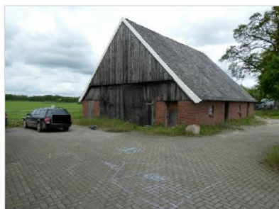
Figuur 2.4 Zuidelijke gevel van de Noordelijke schuur.
