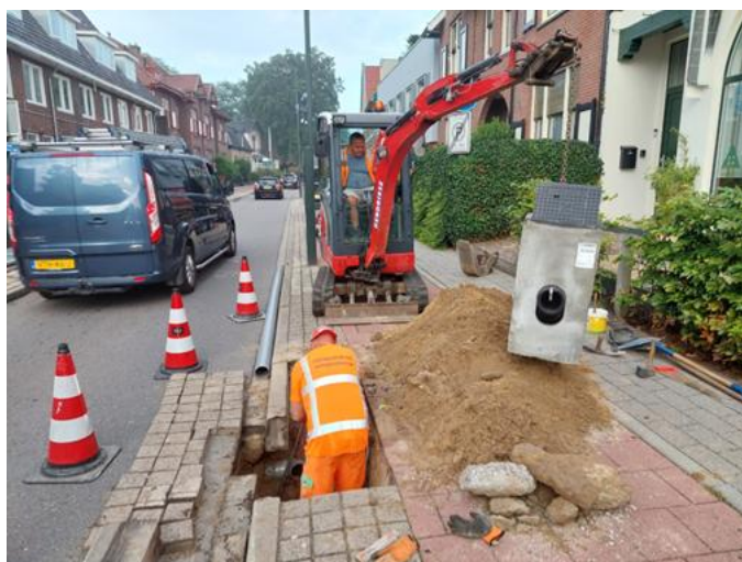
Verruiming capaciteit kolken hemelwater Melkpad
