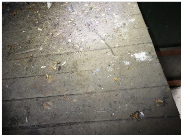
Figuur 5.21 Restanten van huismoeders in de oostelijke loopstal.
