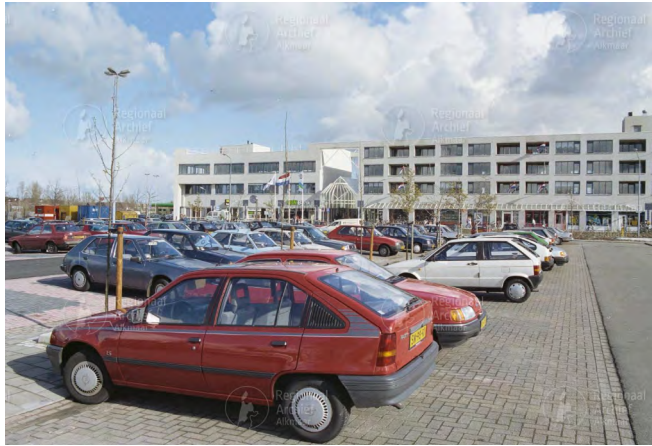
Voormalig parkeerterrein bij het huidige Stadsplein
