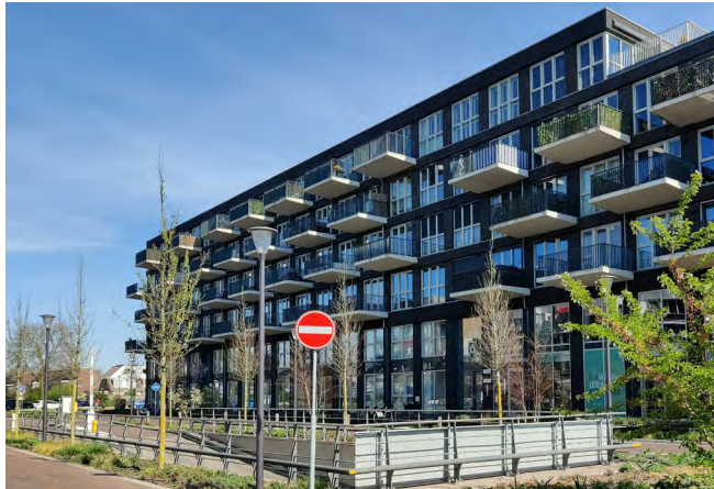
Woongebouw Lapis Lazuli aan het Stadsplein (2019)
