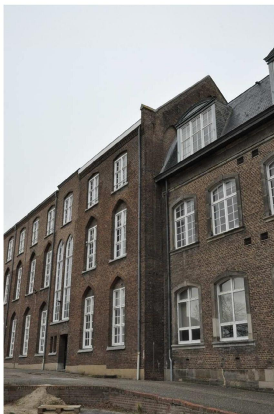
20 De oostelijke topgevel, vanuit het zuiden gezien.
