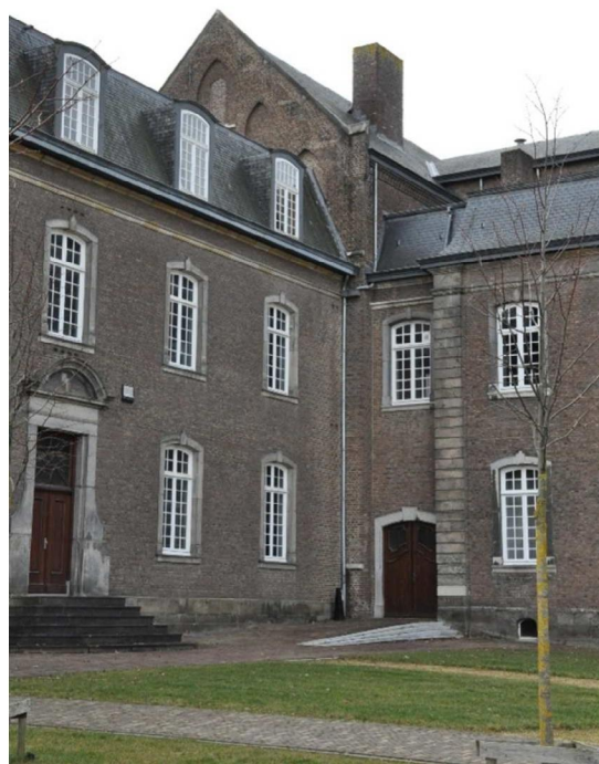
21 De oostelijke topgevel vanuit het noordoosten gezien.
