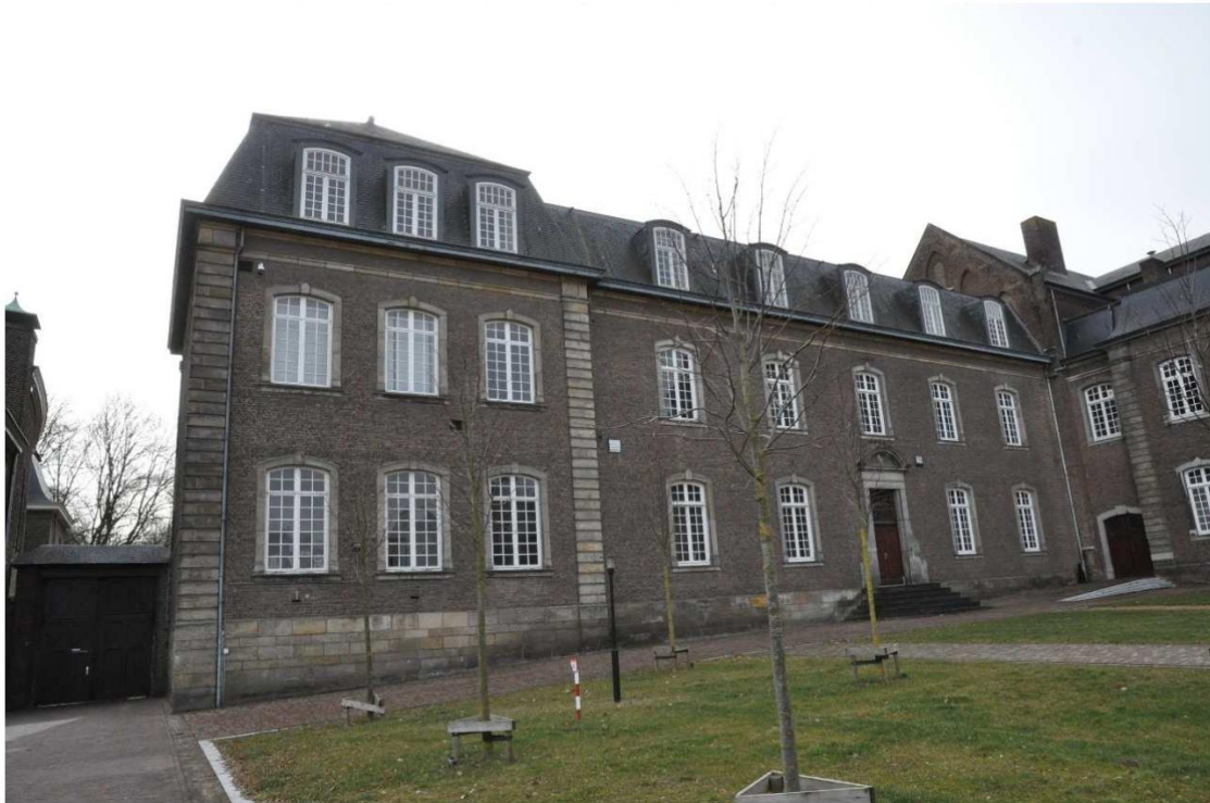
27 De noordgevel van de vleugel uit 1924, richting de formele tuin van de abdij.
