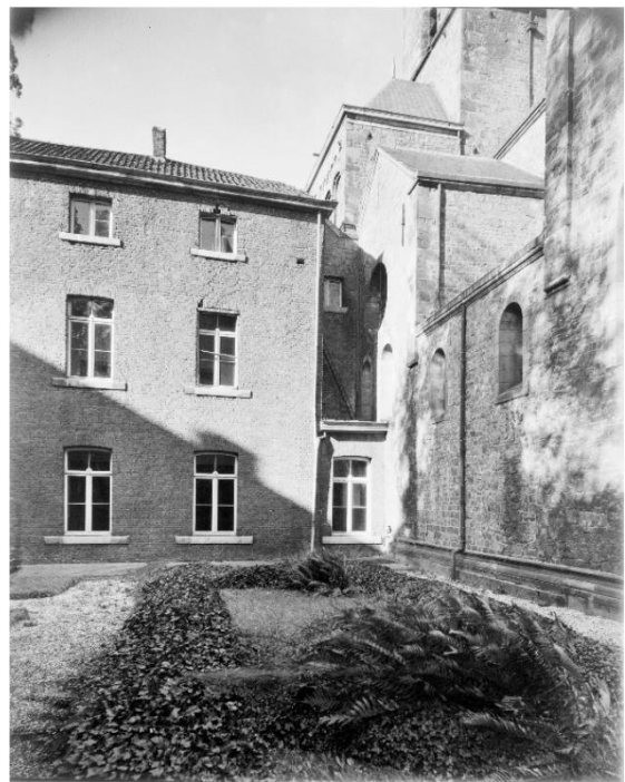
14 Mijnschade in de oostgevel van de westvleugel uit 1849 (foto circa 1975).
