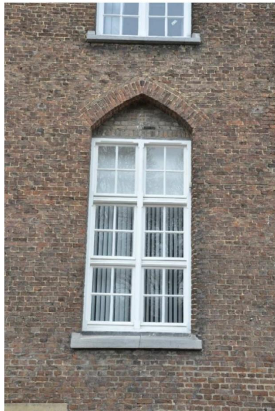
18 Detail van één van de vensters, met vernieuwde ramen.
