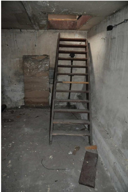
31 De kleine kelder onder het noordoostelijke deel van de gang.
