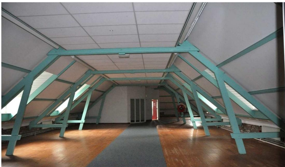
40 De kapconstructie boven de zuidwestelijke vleugel, gemaakt in 1976.
