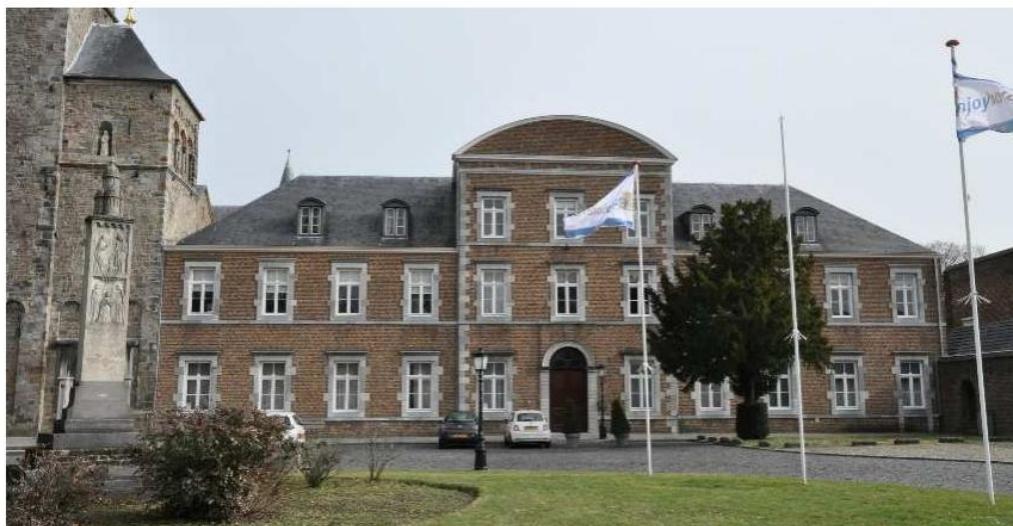
41 De westgevel van de westvleugel, herbouwd in 1977 naar ontwerp uit 1848.
