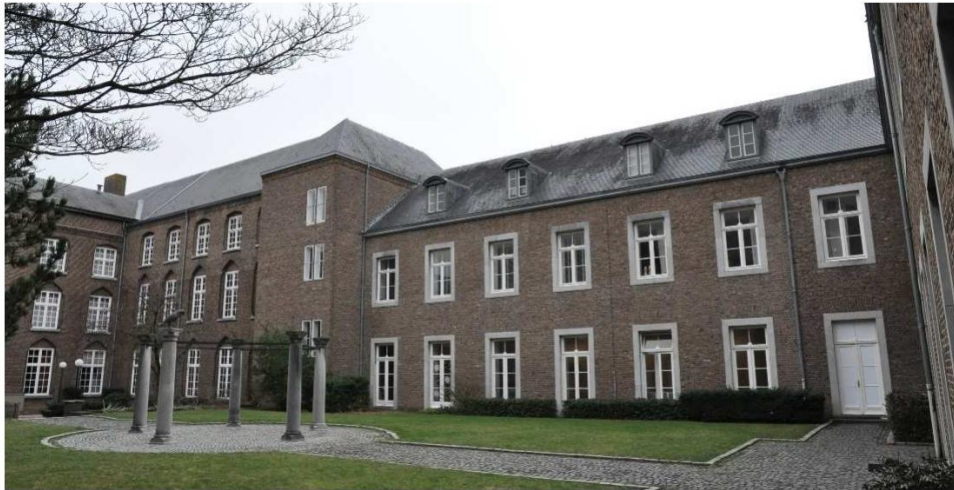
37 De noordgevel van de zuidwestelijke schoolvleugel. Links de uitbouw van het trappenhuis.
