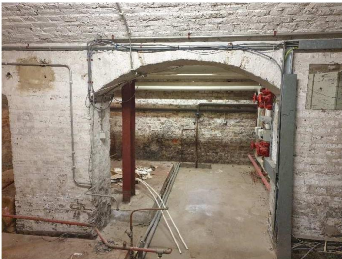
22 Interieur van de kelder uit 1873.
