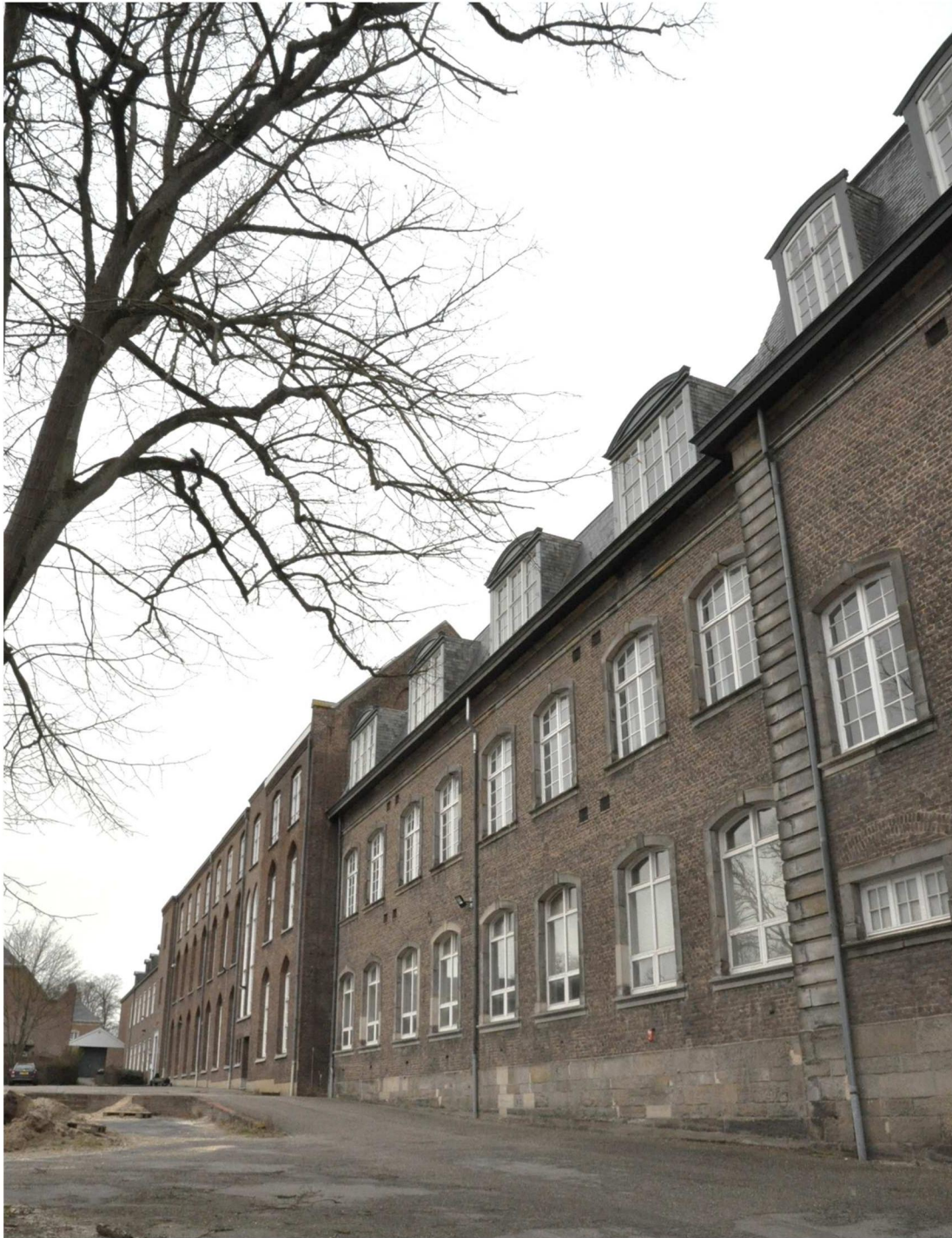
2 De zuidzijde van de schoolvleugel.
