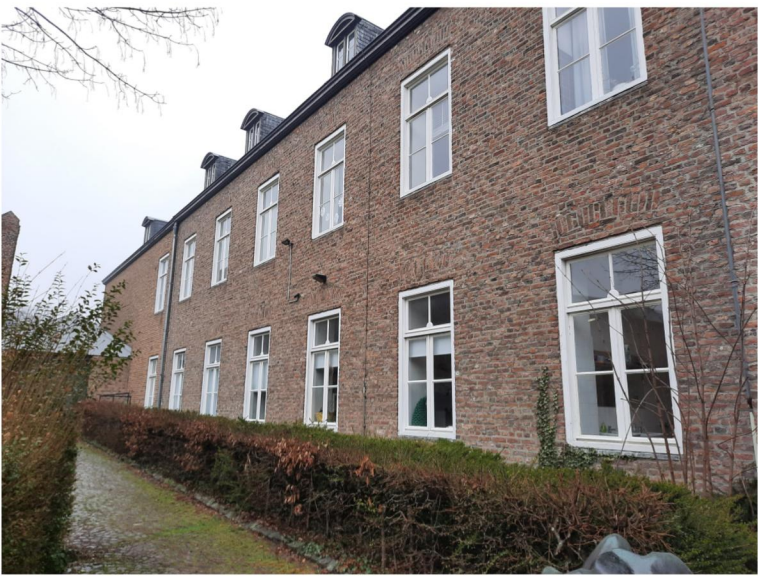
Zuidvleugel - Zuidgevel en kapconstructie
