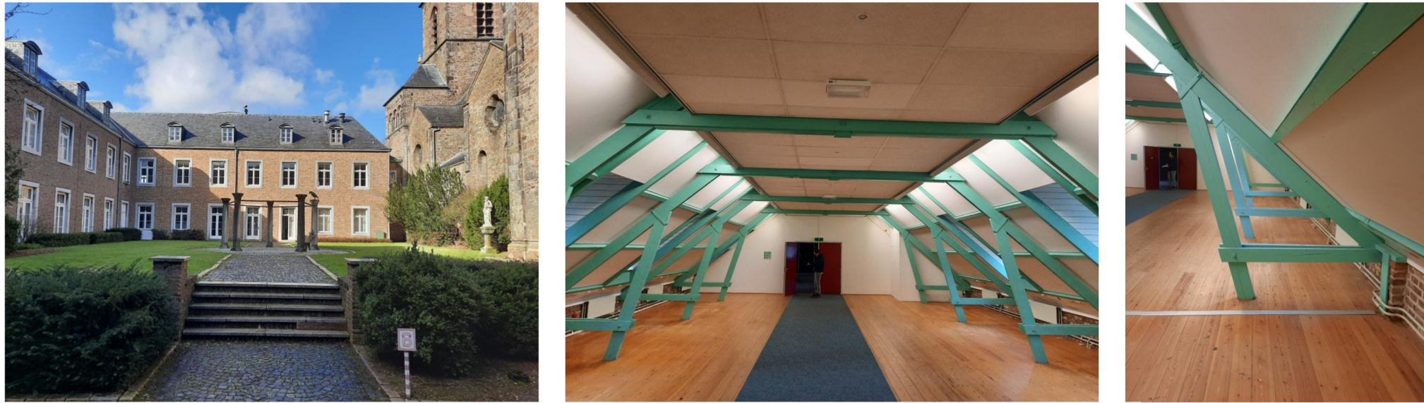
Westvleugel - Oostgevel en kapconstructie
