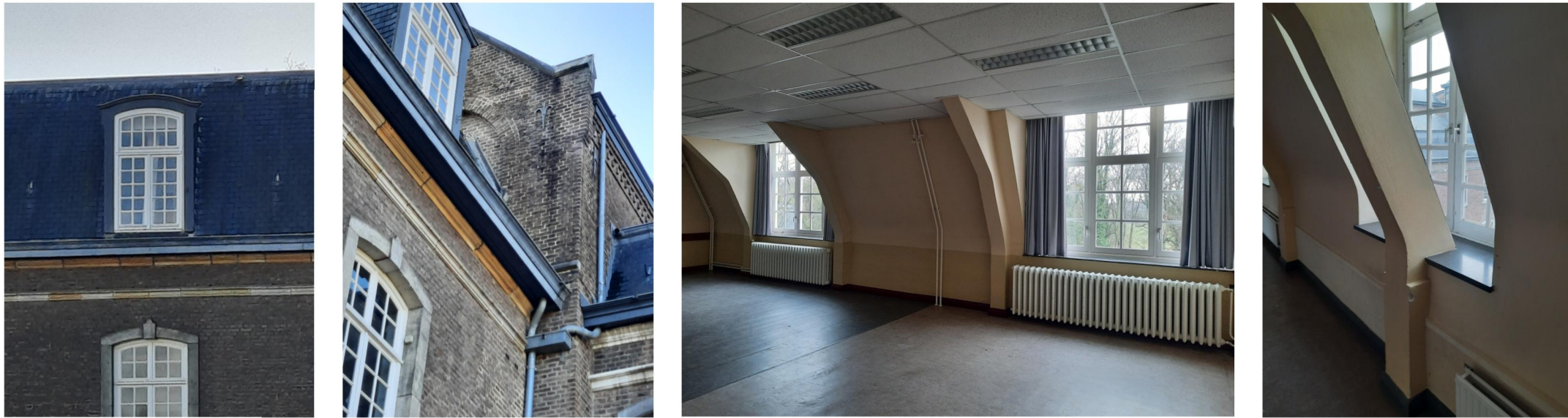
detailfoto's dakkapel en kapconstructie
