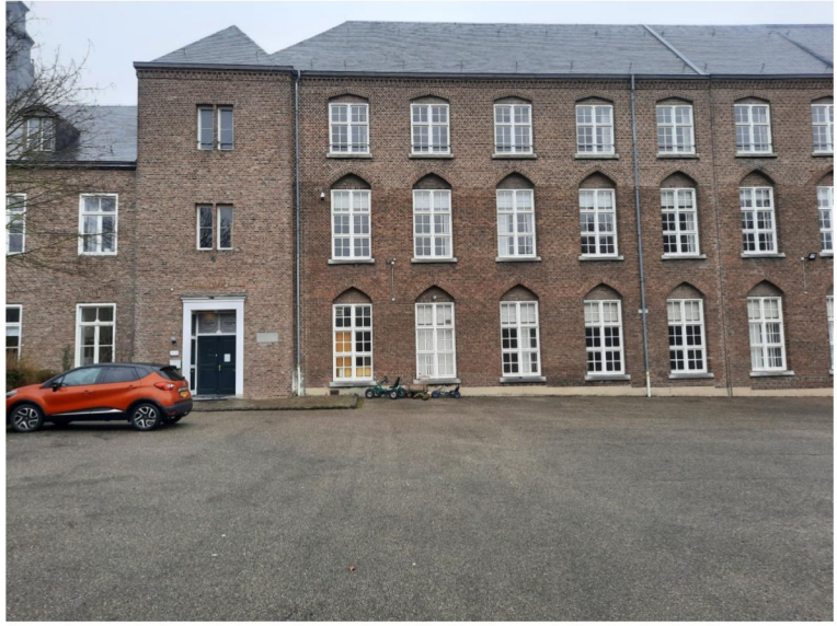
Zuidvleugel - Zuidgevel detailfoto kozijn
