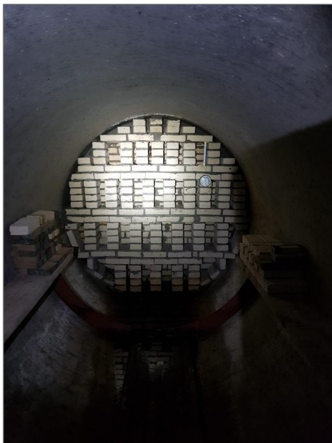
Figuur 17: Achterin deze buis zijn bakstenen gestapeld en gemetseld. Foto: [REDACTED].
