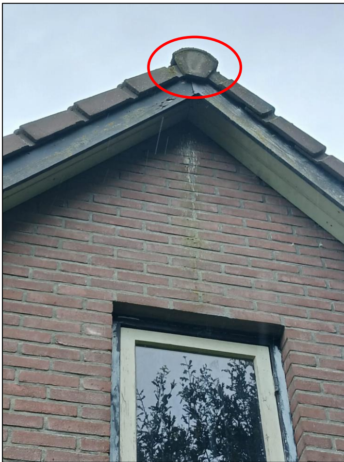
Figuur 5 Mogelijke toegang (rode cirkel) tot verblijfplaatsen gebouwbewonende vleermuizen via de nokpan
