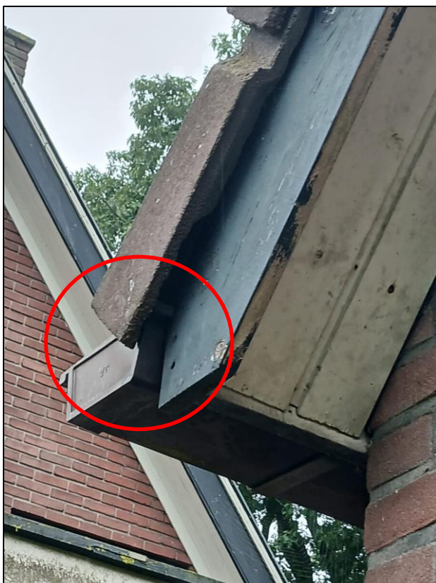
Figuur 11 Toegang tot mogelijke verblijfplaats via dakgoot
