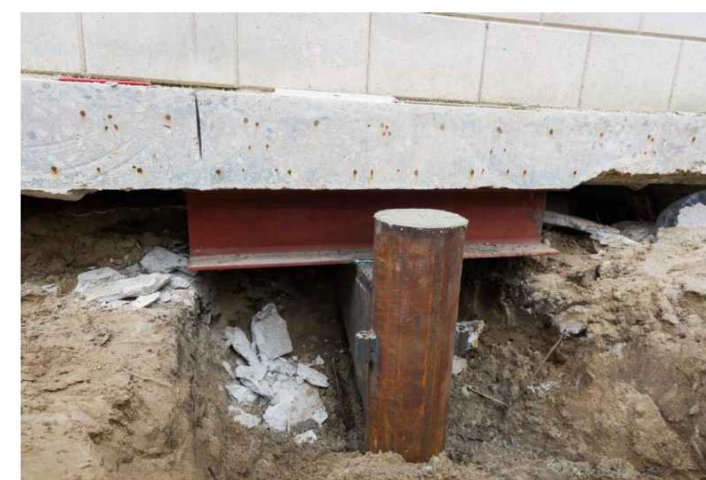
voorbeeld-foto paal met console
